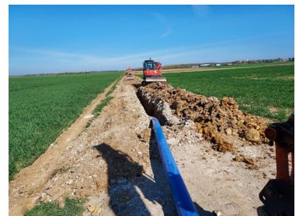
Le tuyau en polyéthylène haute densité est placé en fond de tranchée par les engins de l'entreprise Balestra. Ceux ci tranchent le chemin puis remblaient et roulent de manière à rendre au chemin sa finalité agricole. Le devis prévoit le reprofilage et la remise en état de ce chemin.
