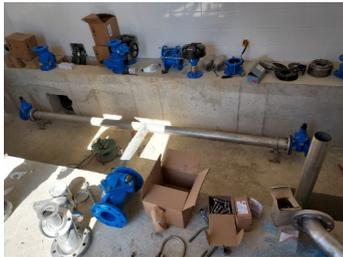
Vue intérieure du bâtiment. L'arrivée des deux pompes fonctionnant en alternance. Tuyau en attente pour refouler l'eau vers le château d'eau.
