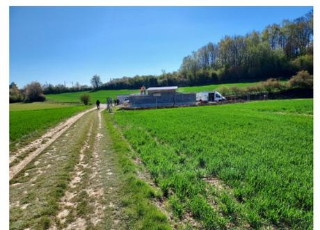
Le bâtiment a un corps central avec de part et d'autre le local abritant les deux pompes. Le bâtiment est surélevé et des merlons doivent le protéger de l'irruption de boue en cas de très gros orages. Le chemin sera reprofilé en ce sens.
