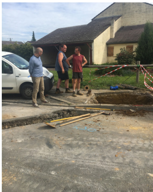
Canalisation pour l'eau potable
