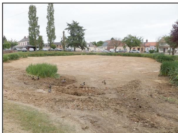
Avec les travaux de la rue Sainneville, la première phase a consisté à passer un collecteur pluvial qui va à la mare et qui collecte les descentes de gouttières, le fil d'eau. Il s'agit de déconnecter du réseau d'assainissement le maximum d'eau pluviale qui n'a rien à faire à la station d'épuration. Ainsi, la mare curée pourra garder une capacité de stockage de 2500 à 3000 m<sup>3</sup>.
